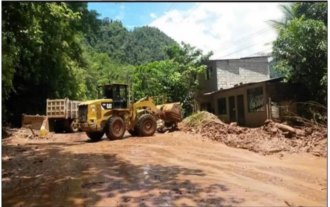
Figura 14. Trabajos del Agrupamiento de Ingeniería PRG en el distrito de San Luis de Shuaro
