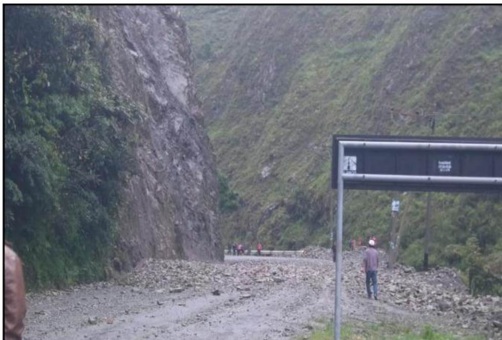
Figura 12. Derrumbe en la carretera de San Ramón
