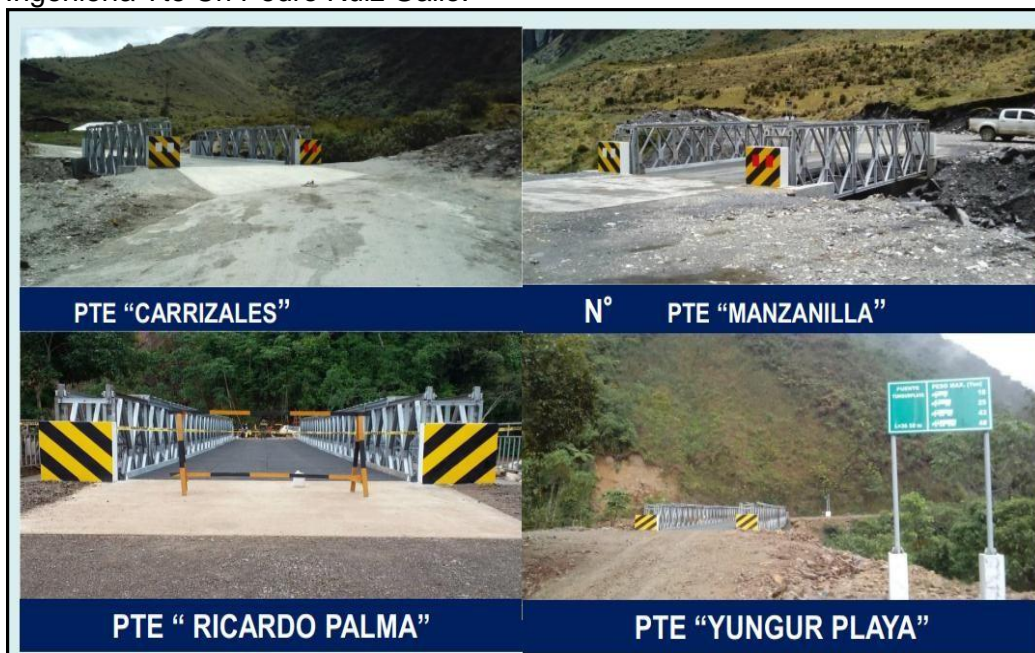
Figura 10. Puentes Acrow instalados por parte de las unidades del Agrupamiento de Ingeniería Tte Crl Pedro Ruiz Gallo.
