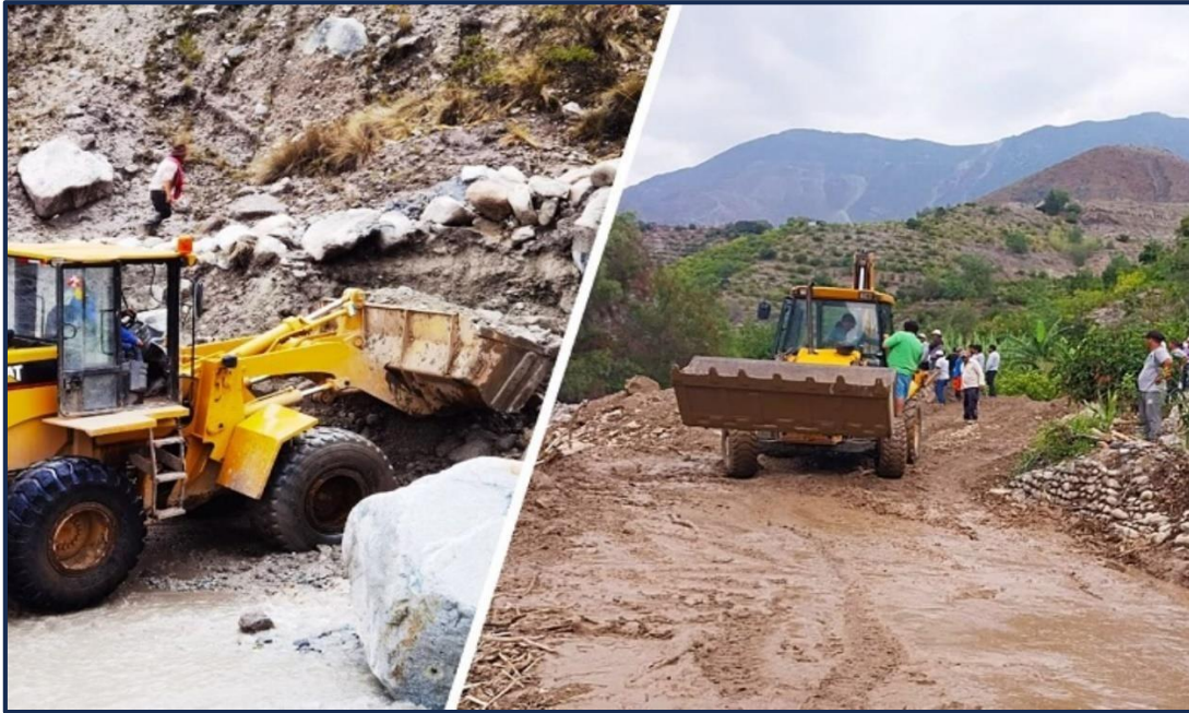
Figura 1. Capacidad logística requerida (Cargadores frontales) para remoción de escombros en los huaycos recurrentes en Mazamari - Satipo.
