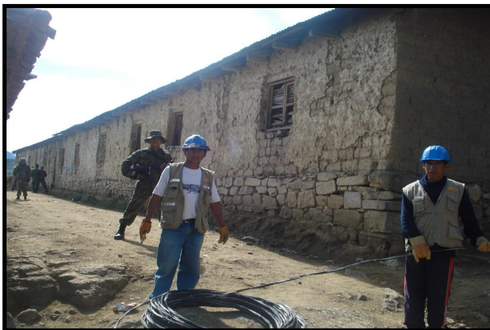
Figura 6. Seguridad durante la Instalación del tendido eléctrico.
