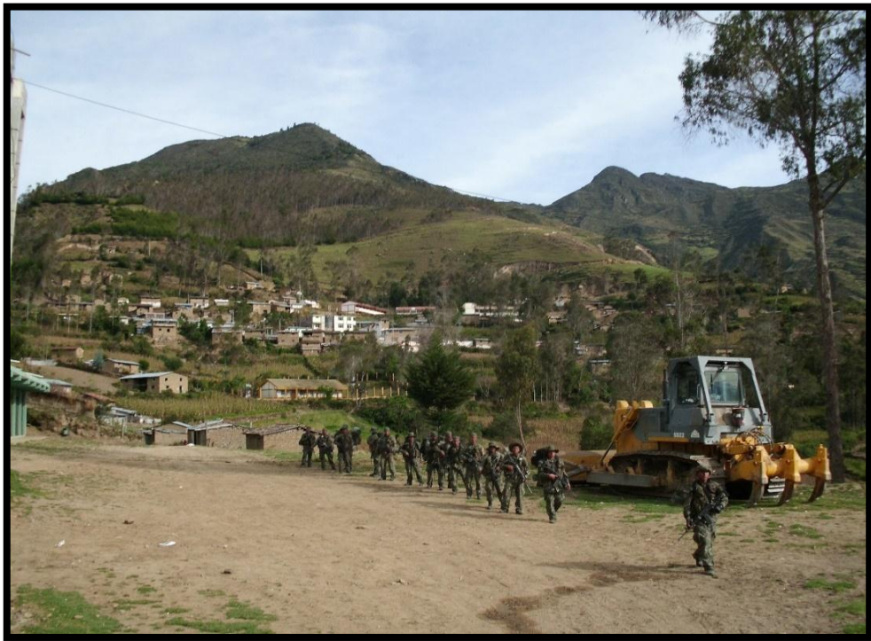
Figura 7. Seguridad durante la Construcción de Tramos de carretera.
